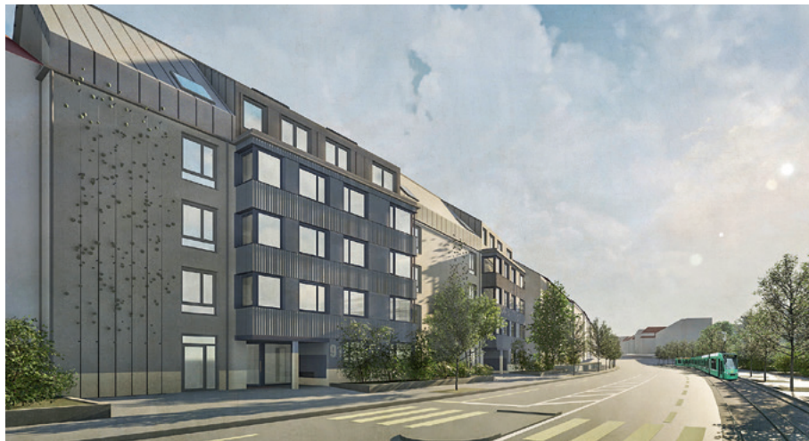
Erfolgreiche Sammelklagen selbst bei Abbruch-Neubauprojekten: Für mehrere Dutzend Neubau-Wohnungen stehen bezahlbare Neumieten in Aussicht (hier: Projekt Luzernerring)
